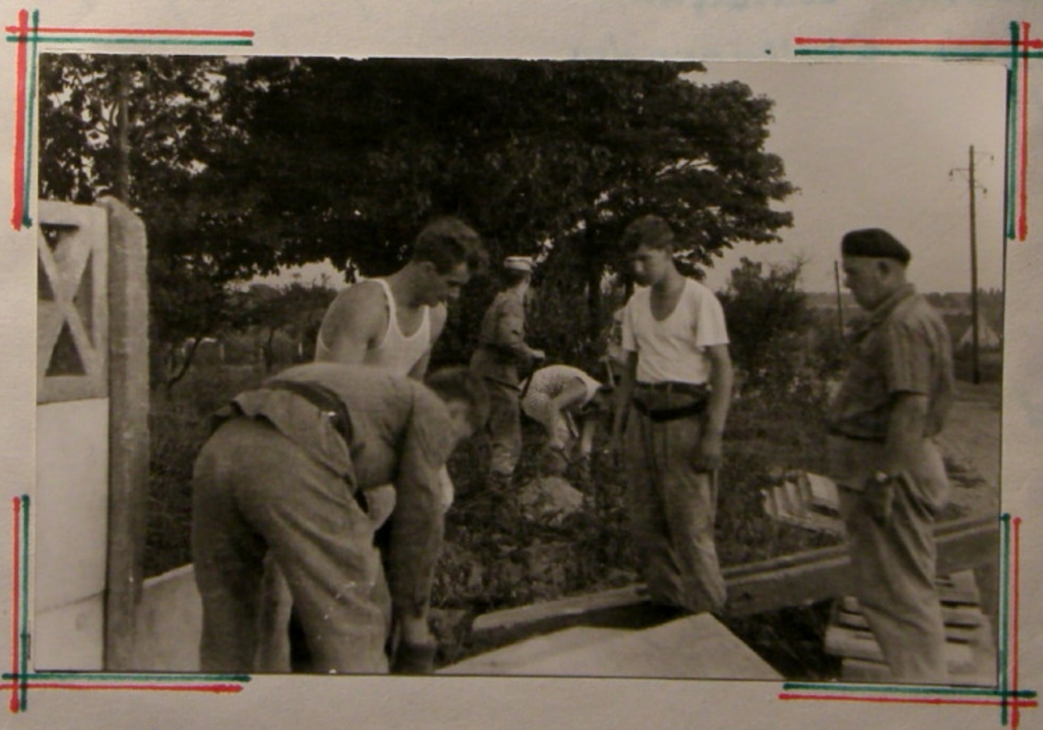
Kol. Jarosław Wasilewski kieruje pracą przy ogrodzeniu.
